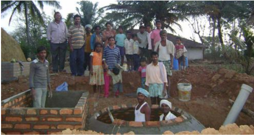
Construction d'une installation de production de biogaz (arrivée de l'installation, réservoir, digesteur - de gauche a droite)
